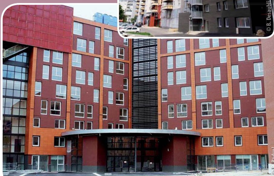
Rénovation urbaine Les Flamants
