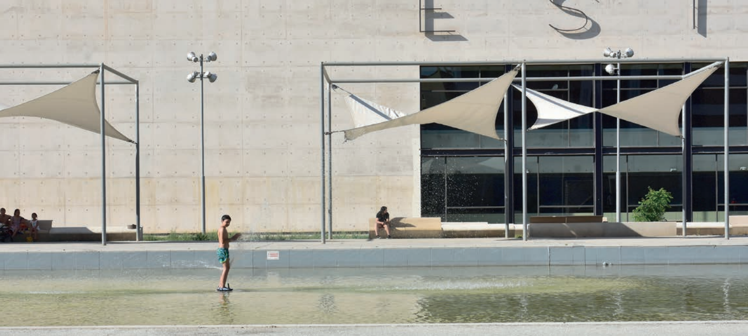
ESTACIÓN DE ZARAGOZA-DELICIAS, SARAGOSSE
