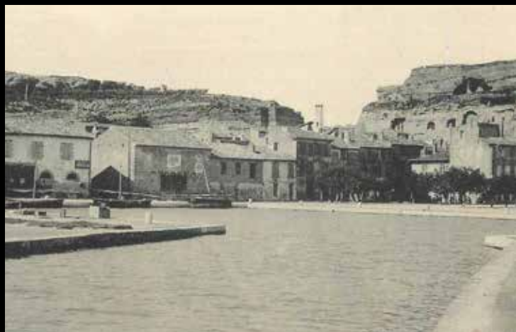
Saint-Chamas, le port vue de la digue
