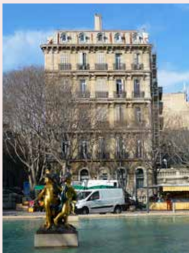
HÔTEL-IMMEUBLE, 24, COURS PUGET (1863), CHARLES BODIN
