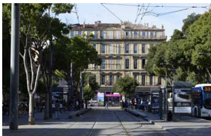
Square Stalingrad - Le balcon filant du dernier étage souligne un niveau socialement mineur mais, en contrepartie, il assure le couronnement de l'ensemble.
