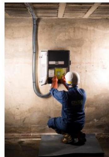
Installation individuelle pour un emplacement ouvert non boxé : coffret électrique, compteur, disjoncteur, prise ou borne
