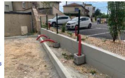
Pose du réseau souterrain pour places ouvertes avec totem
