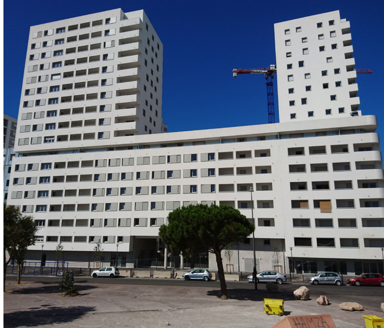
LES DOCKS LIBRES, 3 e ARRONDISSEMENT — Architectes Carta & Associés
