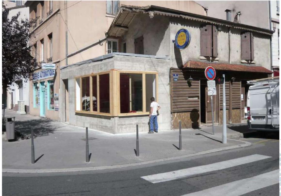
Phase 1 : Coulage des murs BA du restaurant, création d'une étanchéité provisoire, Pose de la menuiserie d'angle, ouverture de la salle du restaurant, Septembre 2011
