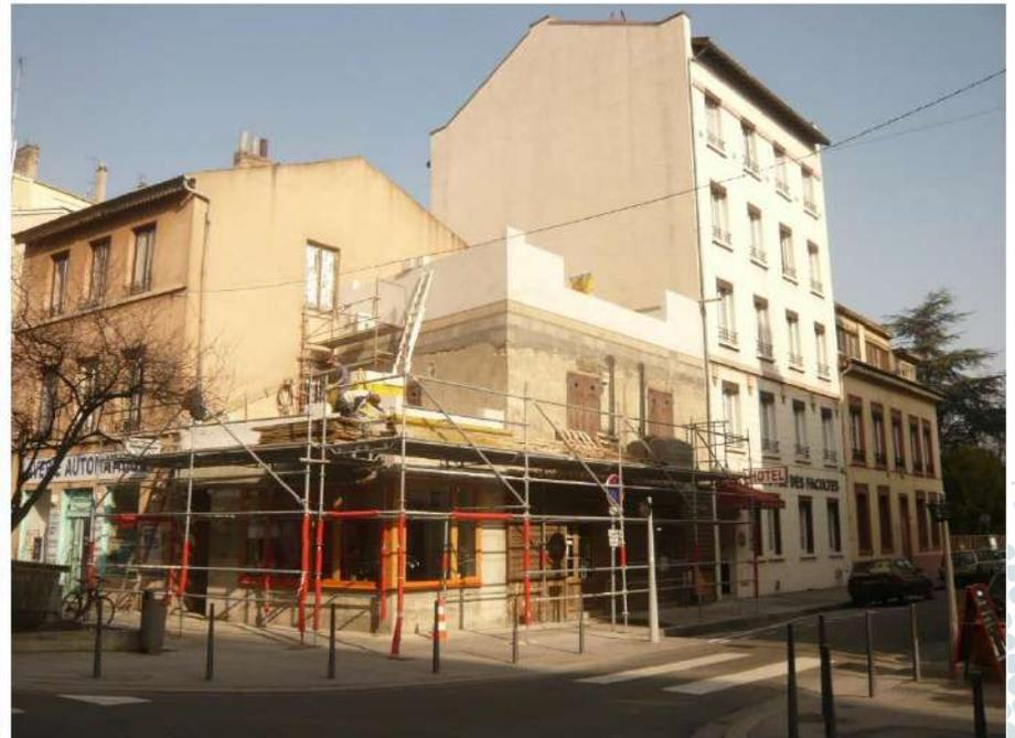
*Phase 2 : Elévation des murs en béton cellulaire sur les deux corps de bâtiment , Mars/Avril 2012*
