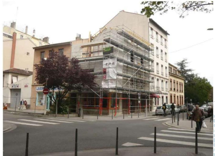
Phase 2 : Elévation des murs en béton cellulaire sur deux niveaux supplémentaires, pose de la charpente bois et tuile , Avril/Mai 2012
