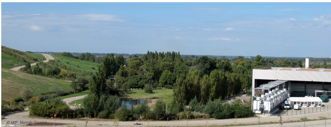
DEPUIS DÉCEMBRE 2015, LA CRAU ÉNERGIES VERTES TRANSFORME LES BIOGAZ DE L'ANCIENNE DÉCHARGE D'ENTRESSEN EN ÉNERGIE
