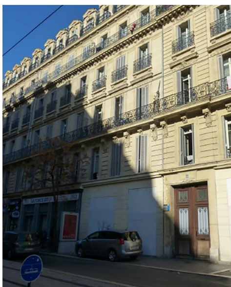
CONSTRUCTION LLS : COLBERT – CENTRE NORD 58 LOGEMENTS Sources : GIP MRU
