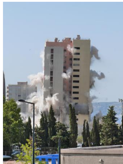
DÉMOLITION: CYPRES B – MALPASSÉ 115 LOGEMENTS Sources : GIP MRU
