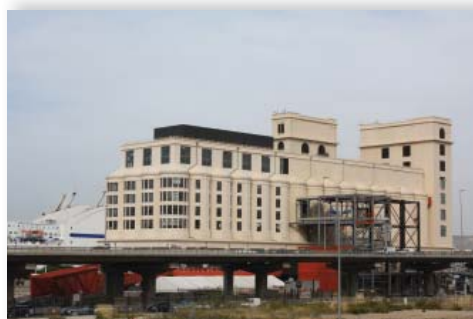
→ Les bureaux du Silo
