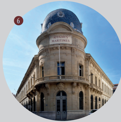
6 LE BÂTIMENT DES AFFAIRES MARITIMES LA JOLIETTE - 2017-2019
