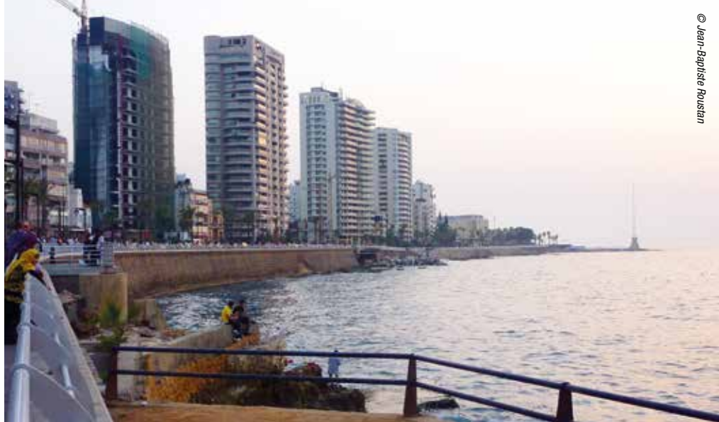
CORNICHE DE BEYROUTH, LIBAN
